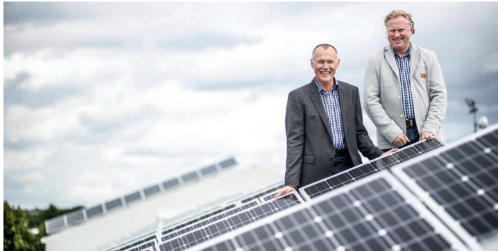
Adsoba-Geschäftsführer Eckhard Aßmus (li.) mit Jochen Baur auf dessen Solar-Dach
