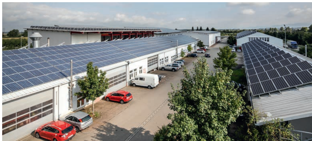
Von oben wird deutlich, wie groß die Dachflächen von Jochen Baur tatsächlich sind
